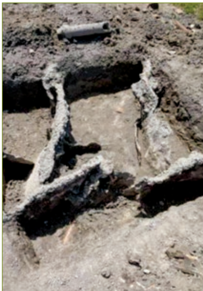
Iskop tla nakon injektiranja smolom
