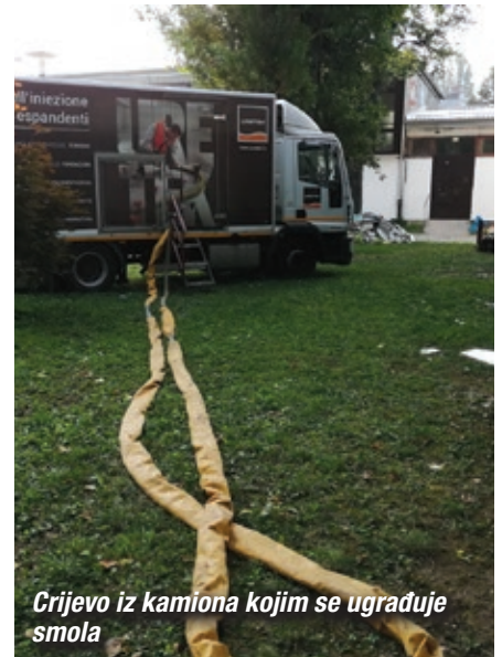
Izgled cijevi spremnih za injektiranje
