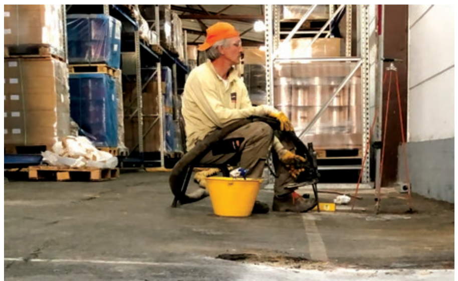
Oprema za injektiranje, mjerni uređaj, crijevo za injektiranje
